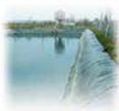
Teljeskörű trágyarendszer rekonstrukció
