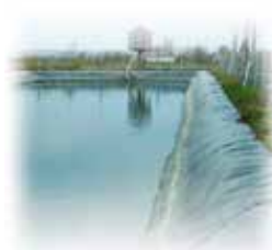
Teljeskörű trágyarendszer rekonstrukció
